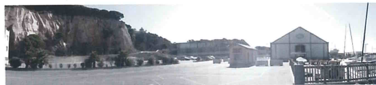
Vista de l'esplanada de la zona E amb l'edifici "Tinglado" i el nou Club Nàutic al fons.
